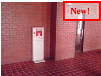
6号館(紫英館)北側ピロティ
