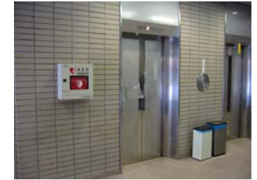
4号館エレベータホール
