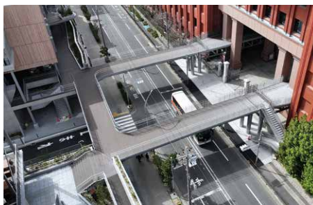
南北エリアを繋ぐ上空通路「結連橋(ゆいれんきょう)」
