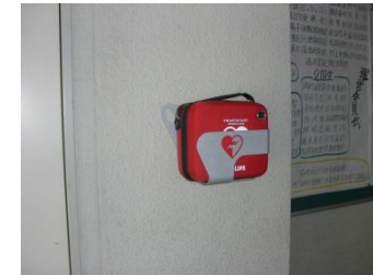
10号館(紫朋館) 工事中 体育館側入口受付向かい
