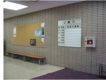
3号館 中央エントランス
