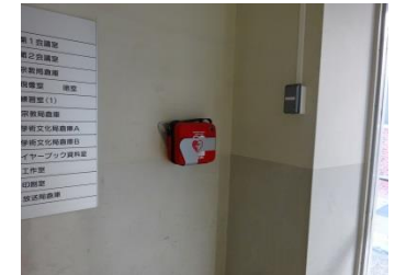
11号館(紫陽館) 工事中 正面入口横
