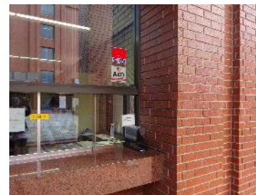
6号館 1階 守衛所(管理人室内)
