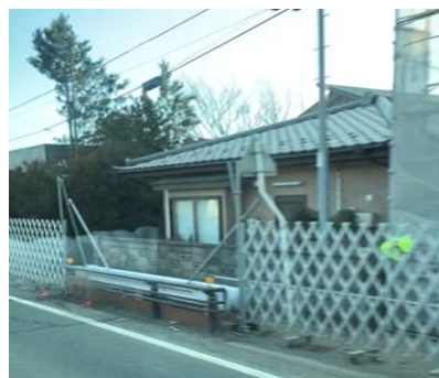
ごく普通の建物の前に設置されている立ち入り禁止の柵
