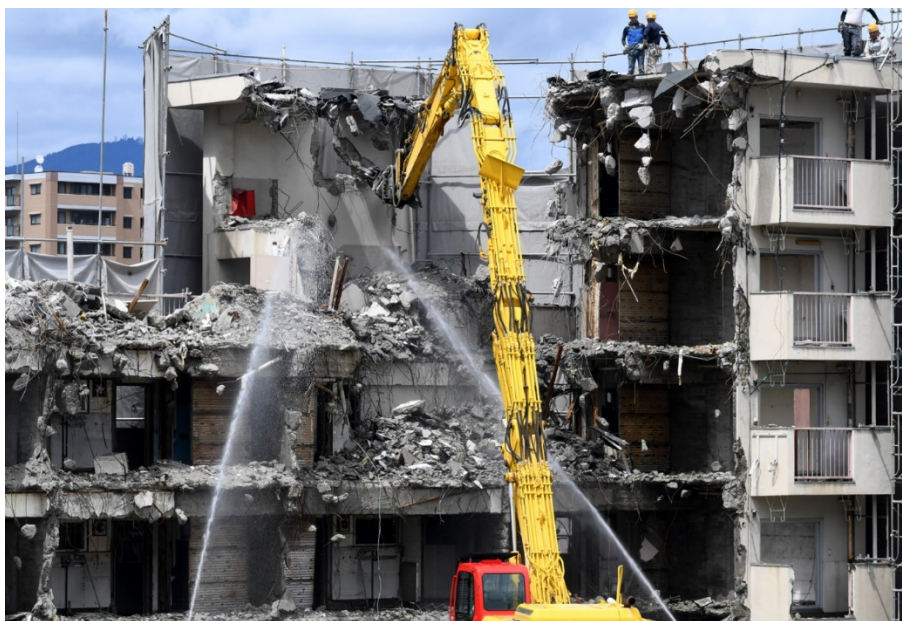
写真3 解体が進む改良住宅＝京都市下京区下之町で2020年7月15日
