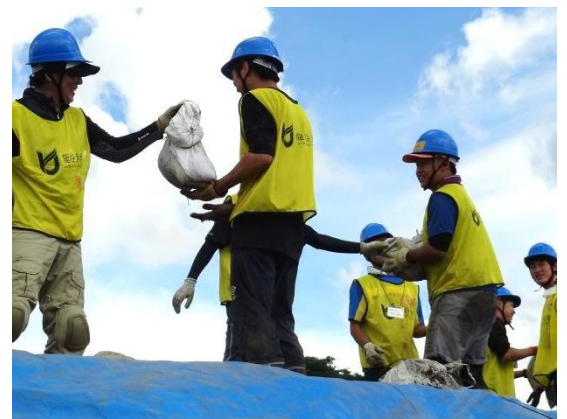
崖崩れを防止するための土嚢を積む作業
