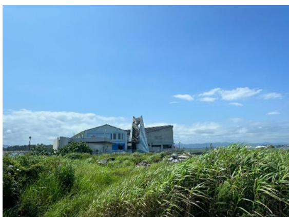
震災遺構 請戸小学校
