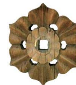
寺院屋根の側面の損傷した六葉
