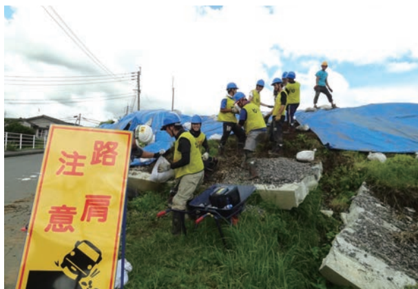
熊本地震で崩れた法面の応急補修作業
