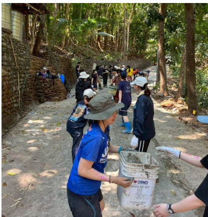
バケツリレーでセメントを運んでいるワークの様子
