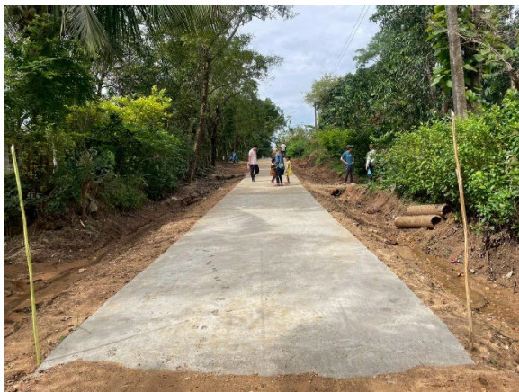
砂利とコンクリートと砂を手ごねで混ぜたセメントワーク 全員で協力して完成した道路の写真
