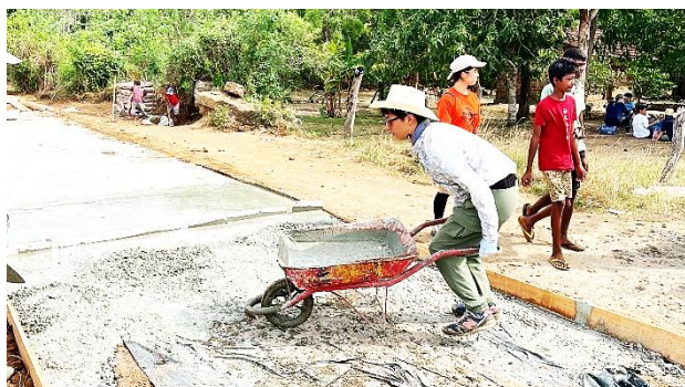
道づくりのワークで、掘った型にセメントやメタルを混ぜたコンクリートを運んでいる様子
