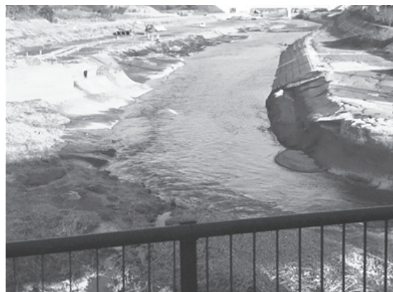
津波に流され建て替えられた際にあえて黒色にしている
