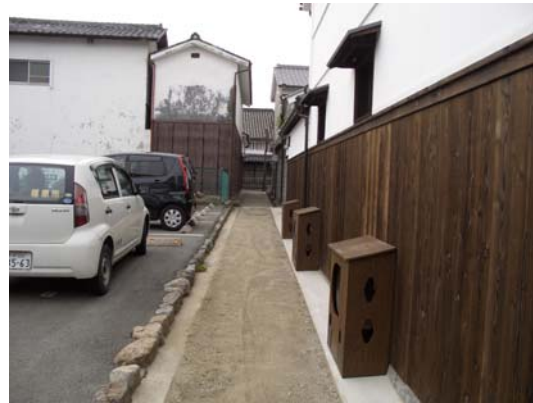
外観に合わせた消火器の収納ボックス
