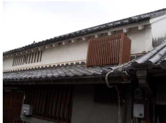
エアコンを隠す細工
